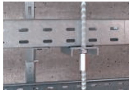
Menetes rúd rögzítése többszintű tálcák elrendezés esetén
