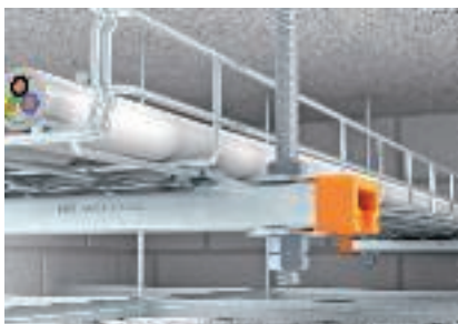
Rögzítés a nagy terhelhetőség érdekében
