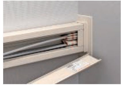
Jelölés elhelyezése a csatorna belső részén
