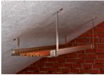
Szerelés dőlt mennyezetre, egyedileg igazított födémkengyellel
