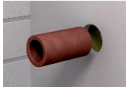
A csőháj beillesztése a szerelt falba
