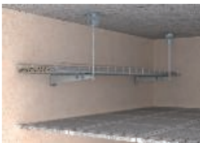
Fali szerelés, egy- és kétszintes kialakítás lehetséges
