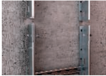
Toldás kialakítás csavarozott hosszoldóval
