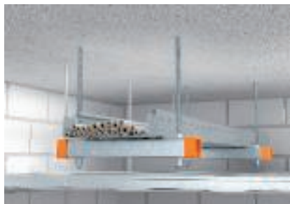
Egyszintes mennyezeti szerelés tűzvédelmi álmennyezet felett
