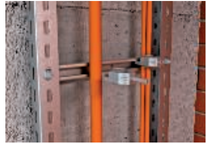
A kábelek rögzítése kengyeles bilincsekkel, csoportos elhelyezés is lehetséges
