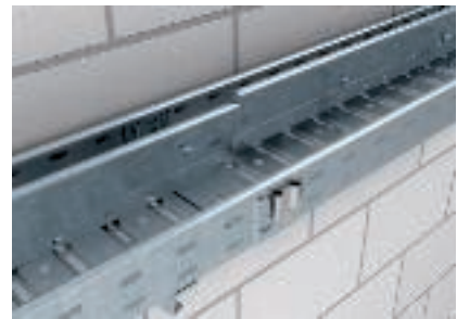
Elválasztó szerelése félgömbfejű csavarral
