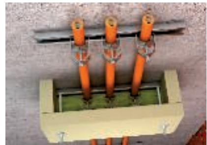
Hatásos alátámasztás ZSE90 húzásmentesítővel
