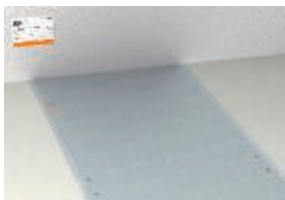
Láthatatlan tűzgátló tömítés esztrichel színelő csatornában
