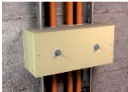
Hatásos alátámasztás ZSE90 húzásmentesítővel
