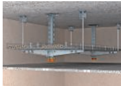
Kétszintes földműfüggesztés kétoldali konzolelhelyezéssel
