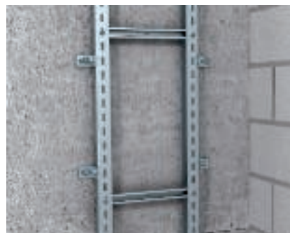
Nehéz kivitelű kábelhágcsó falra rögzítése Az SLM 50 típusú, nehéz kivitelű kábelhágcsó falra rögzítése BW típusú rögzítőszeglettel.
