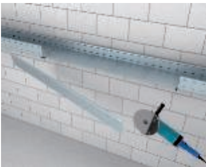
T-leágazóidom készítése beépíthető sarokelemmel Az oldalpofa kitörése végigmenő nagyfeszítvú tálcából.
