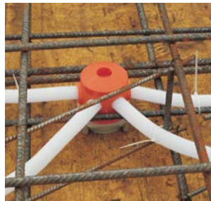
A vízszintes zsaluzaton való alkalmazás példája.
