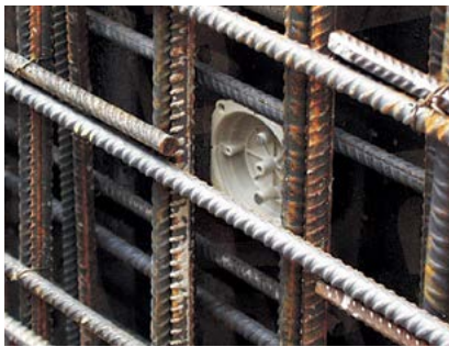
A zsaluzatra erősített KBV fedél.
