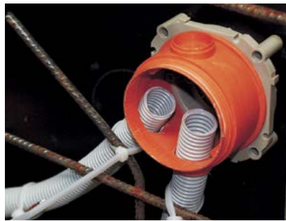
A KBT palástjába szerelt hajlékony csövek.
