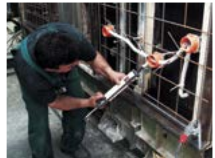
Az átvezetések tömítése (gitt).
