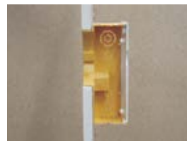
3) Az oldalnézet a dobozra (metszetben), amely a gipsztábla alsó oldaláról van betéve.
