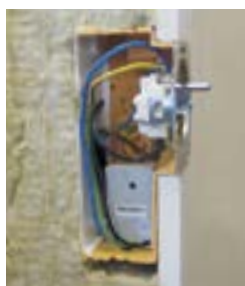
5) Példák a dobozok használatára (metszetben): pl. túlfeszültség védelem behelyezése, kábelbilincs szerelése, rugós vezetékösszekötők használata, S-66 típusú sorkapocs használata.
