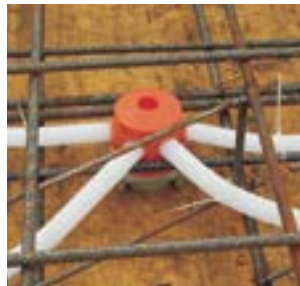
A vízszintes zsaluzaton való alkalmazás példája.
