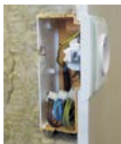
5) Példák a dobozok használatára (metszetben): pl. túlfeszültség védelem behelyezése, kábelbilincs szerelése, rugós vezetékösszekötők használata, S-66 típusú sorkapocs használata.
