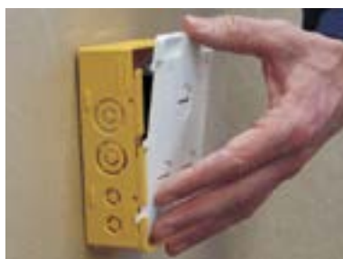
2) A KUH 1/L típusú dobozt beszereljük az előkészített nyílásba és az aljával lezárjuk.
