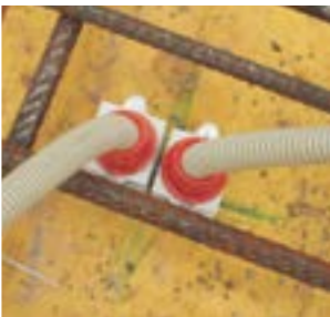
A végelem és a kivezető alkalmazásának példája.
