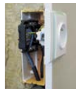
5) Példák a dobozok használatára (metszetben): pl. túlfeszültség védelem behelyezése, kábelbilincs szerelése, rugós vezetékösszekötők használata, S-66 típusú sorkapocs használata.
